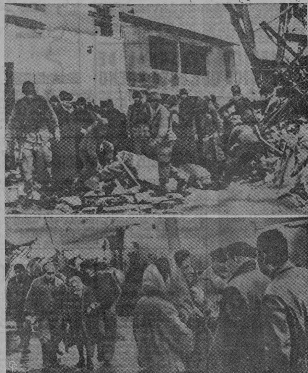
INUNDACIONES EN FRANCIA.—Trabajadores de rescate (arriba) buscan cadáveres en las ruinas de los edificios de Frejus, Francia, azotados por una inundación originada por las aguas del dique Malpasset, que hizo explosión enviando una pared de agua de 35 pies hacia el pueblo Riviera. Abajo, algunas de las mujeres sobrevivientes son asistidas por trabajadores de rescate. Según se informó, más de 300 perdieron la vida en el valle, a lo largo del cual las aguas destrozaron cuanto encontraban a su paso, incluyendo casas y puentes.
